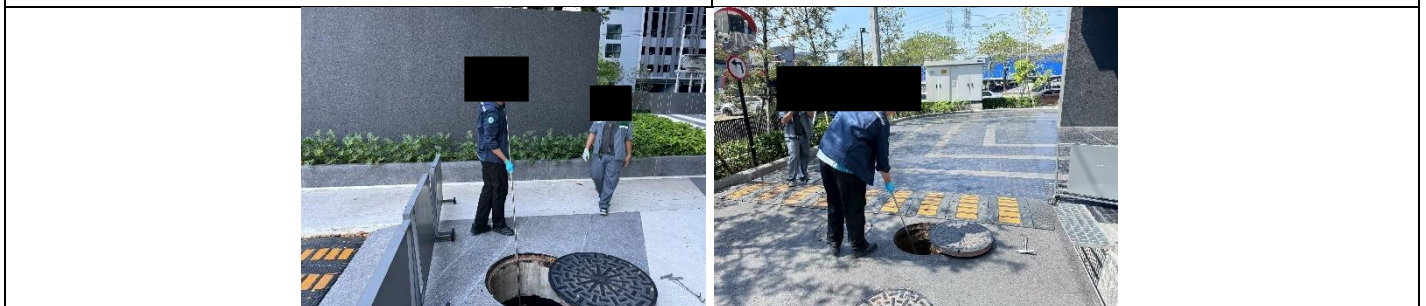
รูปที่ ผ7.13 บ่อตรวจคุณภาพน้ำทั้งภายหลังการบำบัด และก่อนระบายออกสู่ภายนอกโครงการ
