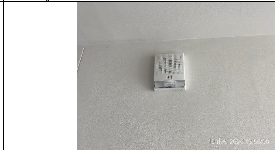
รูปที่ ผ7.58 กริ่งสัญญาณเตือนอัคคีภัย (Fire alarm bell)
