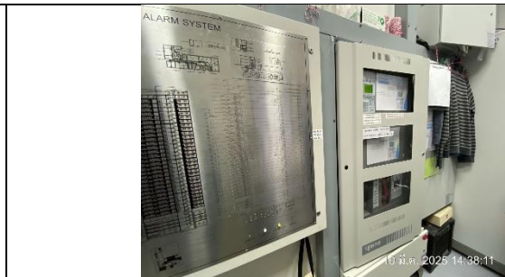
รูปที่ ผ7.54 แผงควบคุม (Fire alarm control panel : FCP)
