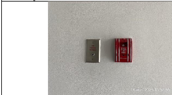
รูปที่ ผ7.57 เครื่องแจ้งเหตุโดยใช้มือถือ (Fire alarm manual station) และโทรศัพท์ฉุกเฉิน (Telephone Jack)
