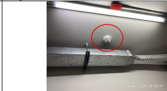
รูปที่ ผ7.56 เครื่องตรวจจับความร้อน (Heat detector)
