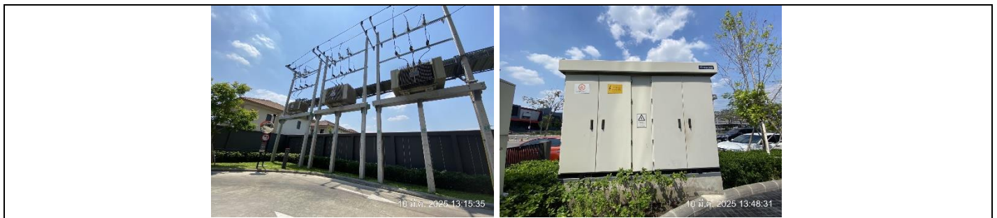
รูปที่ ผ7.40 หม้อแปลงไฟฟ้า
